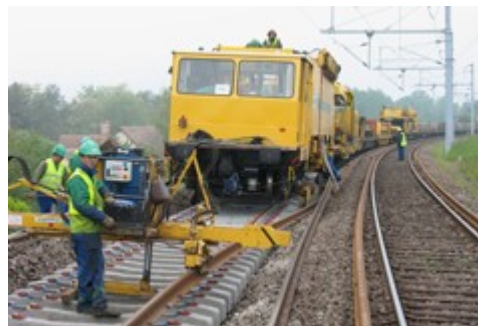
Longs Rails soudés sur traverses béton
